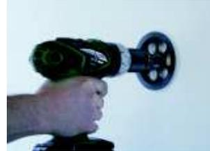
Aplicar MARCOTHERM COLLA PU sobre la superficie circular de los discos de fijación MTH ANELLO.
